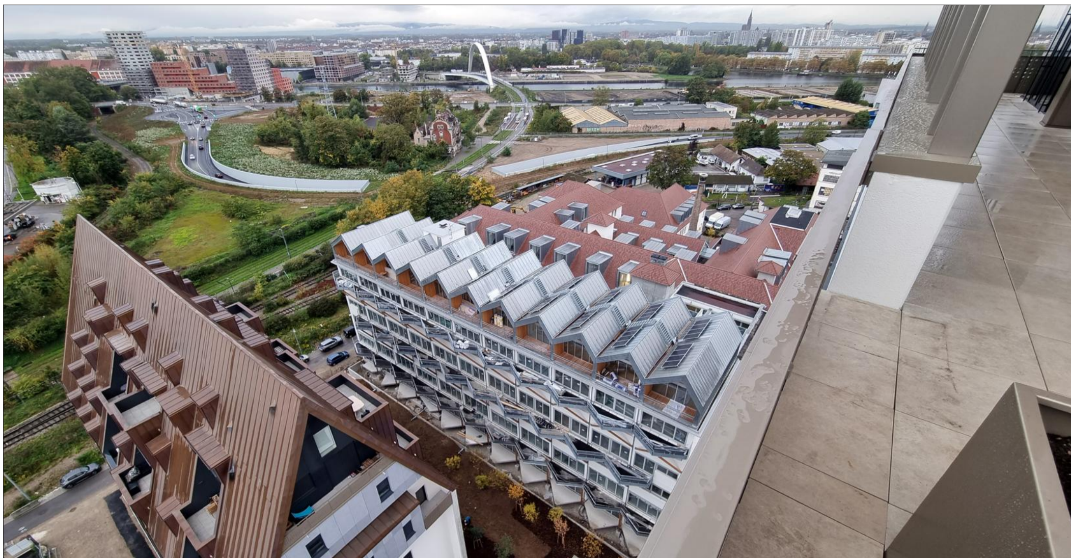
En lieu et place d'une usine coopérative devenue une sombre friche, un nouveau morceau de ville dessiné pour faire le trait d'union entre le centre et l'ouest de la ville. Photos DNA/Laurent RÉA
